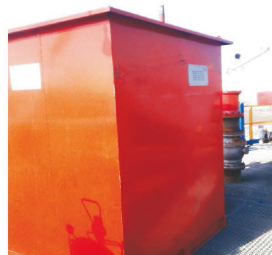
内蒙千里山LNG项目干粉灭火装置
