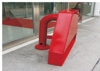
用于外浮顶储罐的立式空气泡沫产生器
