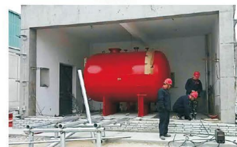
内蒙古上海庙换流站施工现场
