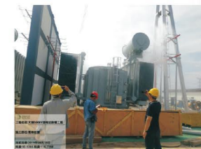
江苏镇江大港500千伏输电工程
