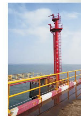
福建中油油品仓储有限公司 (石狮油库码头) 施工现场
