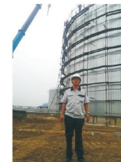
大庆油田施工现场
